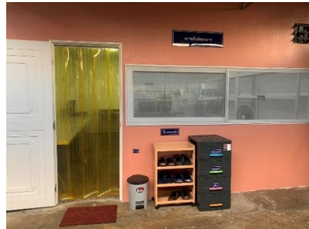
ข) ลักษณะพื้นที่หลังการปรับปรุงทัศนียภาพและโครงสร้างพื้นฐาน
